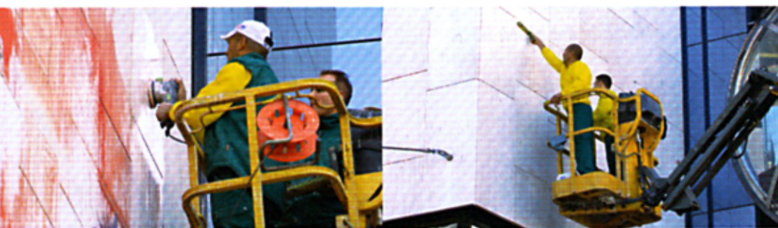
Extrem heikel und anspruchsvoll: Schmierereien an porösen Natursteinfassaden (im Bild italienische Kalksteinfassade am ATAG-Gebäude) lassen sich nur wegschleifen. Pro Tag schaffen zwei Mann gerade mal fünf bis zehn Quadratmeter.
