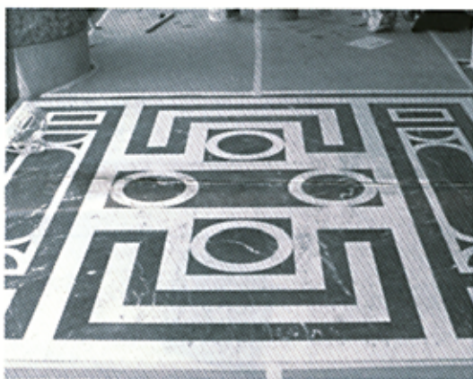
Steinboden der Stiftungsbibliothek Werner Oechslin in Einsiedeln (Bau von Mario Botta), vor und nach der Veredelung. Der Boden wurde mit einem sogenannten Planschliff 220 (Seidenglanz) veredelt.
