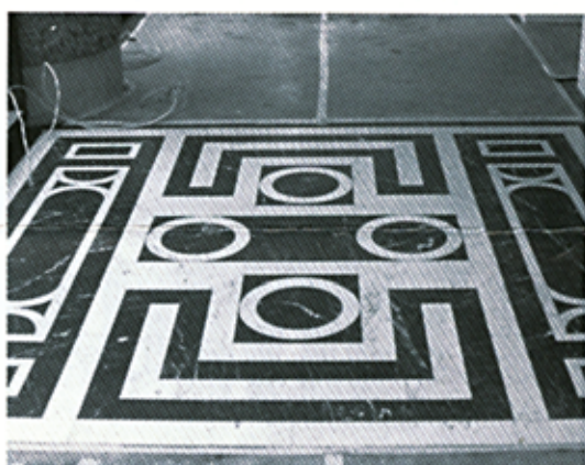
Steinboden der Stiftungsbibliothek Werner Oechslin in Einsiedeln (Bau von Mario Botta), vor und nach der Veredelung. Der Boden wurde mit einem sogenannten Planschliff 220 (Seidenglanz) veredelt.
